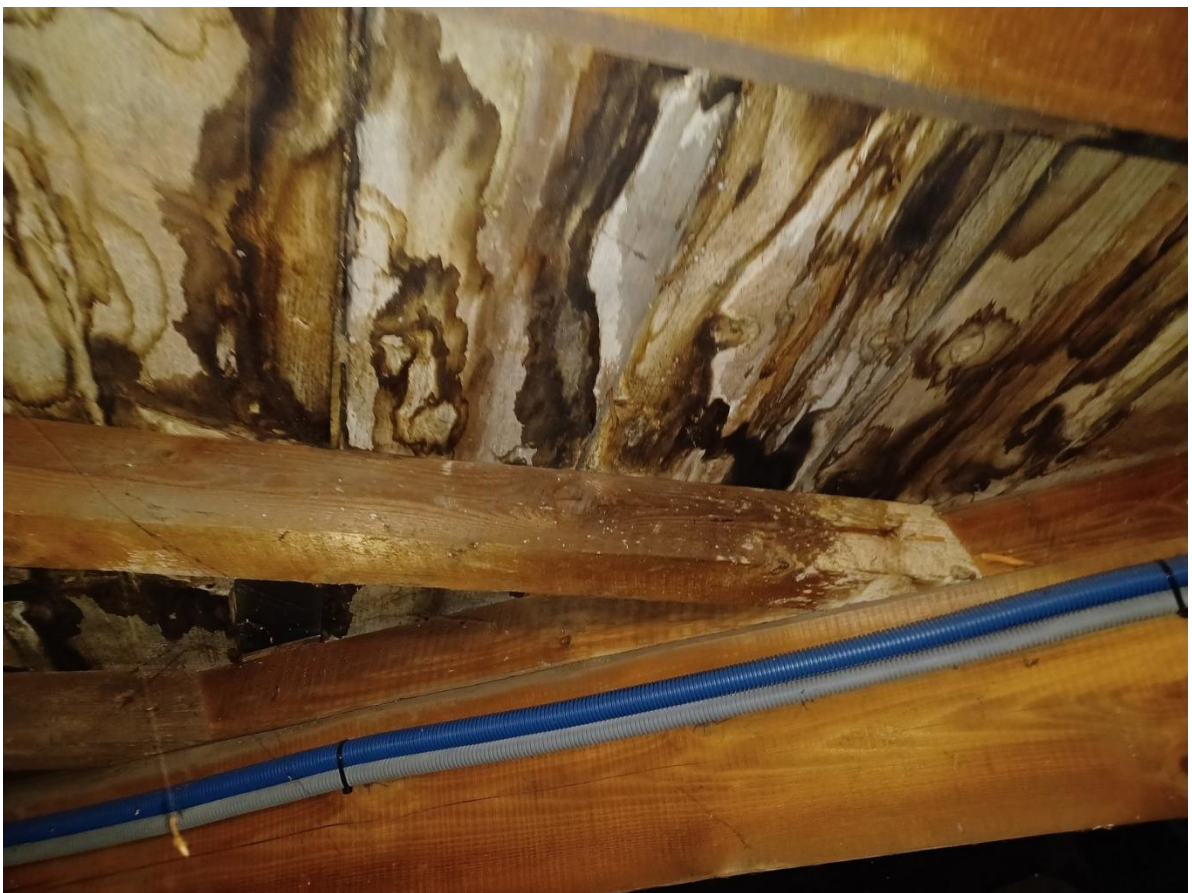
Figure 40: Zone entre files 4 et 5 et files B et C - chevrons altérés vers infiltrations
