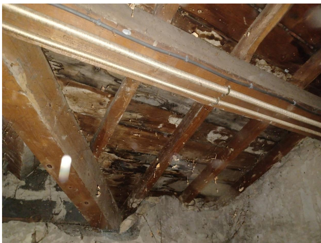
Figure 28: zone entre files 2 et 3 et files B et C - pannes et chevrons ; infiltrations
