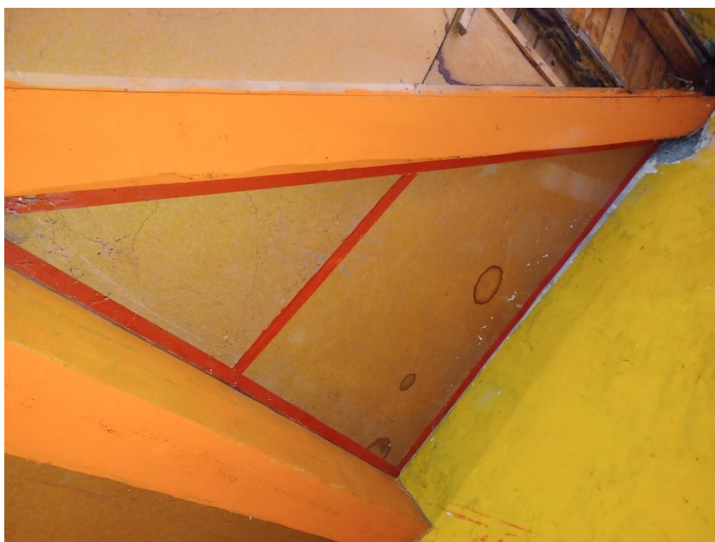
Figure 16: zone entre files 3 et 4 et files A et D - nombreuses traces d'infiltrations
