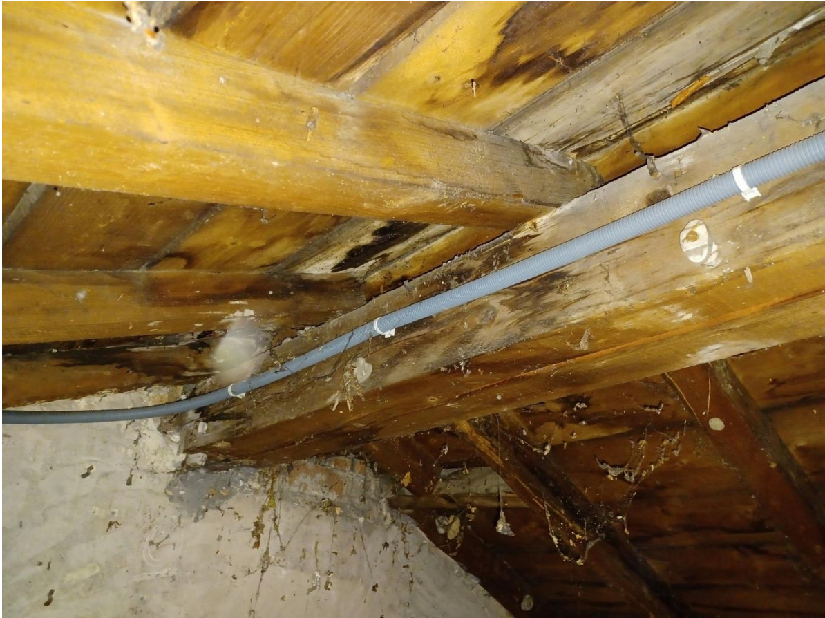
Figure 37: Zone entre files 4 et 5 et files B et C - panne - infiltrations
