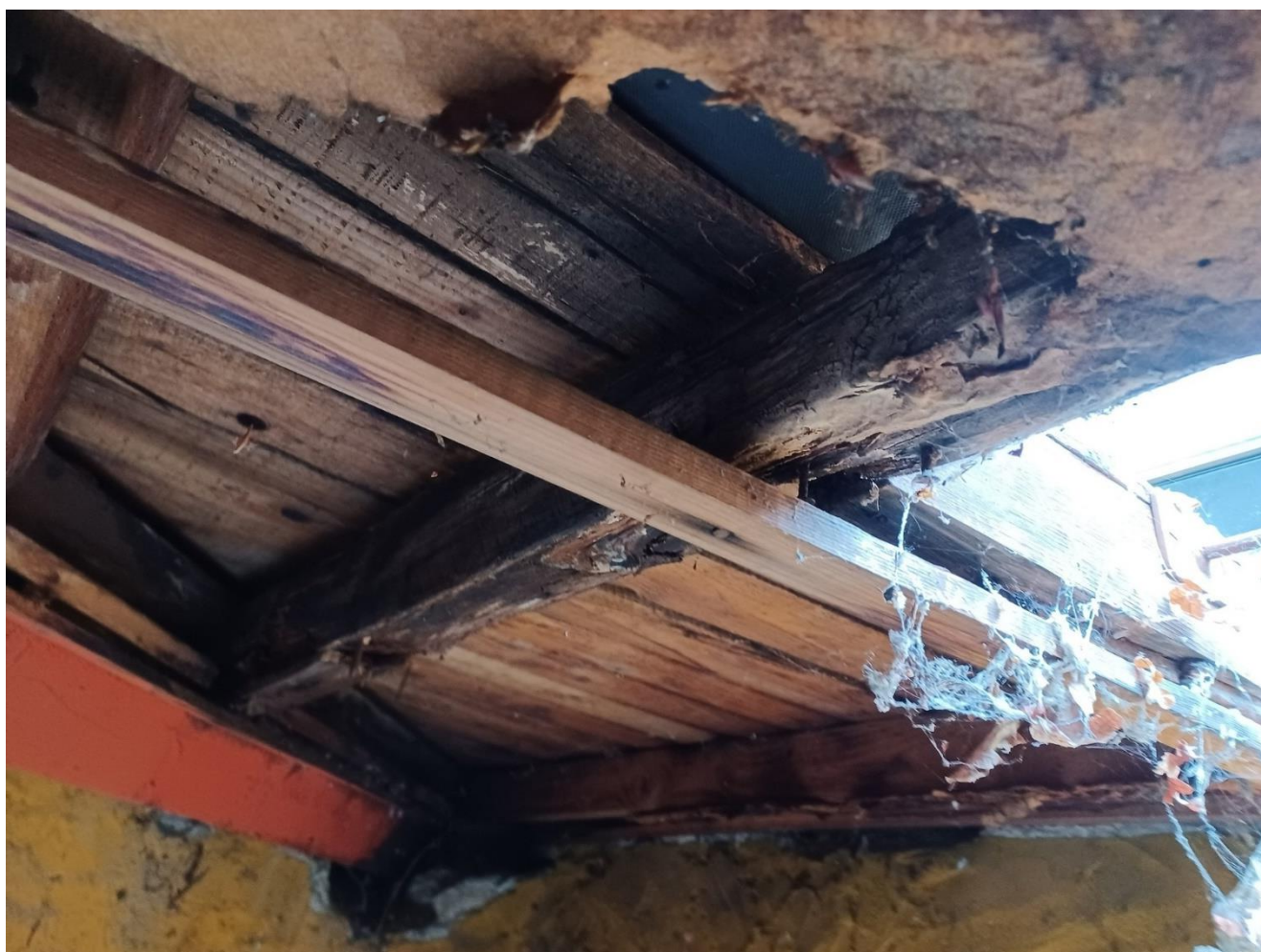
Figure 18: zone entre files 3 et 4 et files A et D - chevron altéré vers chevrete
