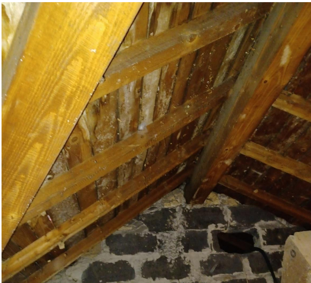
Figure 35: Zone entre files 4 et 5 et files B et C - pannes et chevrons
