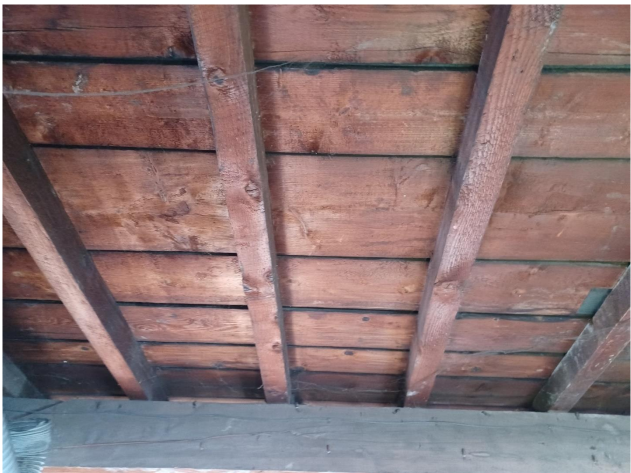
Figure 30: zone entre files 2 et 3 et files B et C - panne et chevrons
