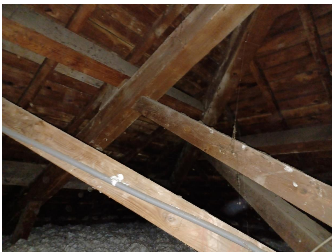
Figure 22: zone entre files 2 et 3 et files C et E - pas de dommage structurel visible
