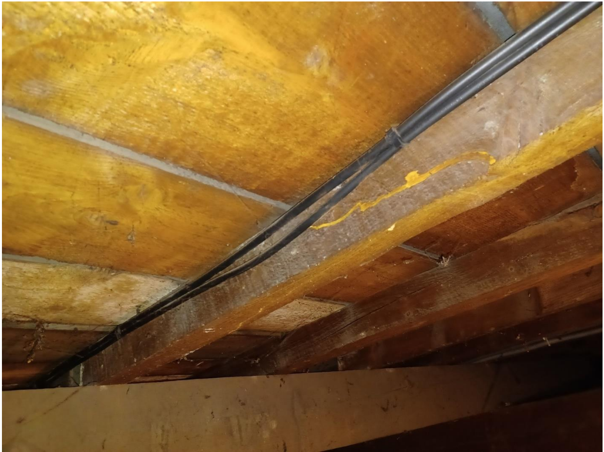
Figure 39: Zone entre files 4 et 5 et files B et C - chevron rompu
