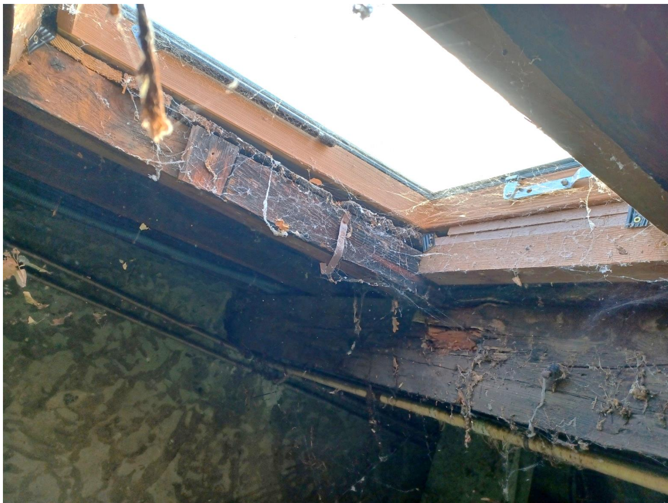
Figure 31: zone entre files 2 et 3 et files B et C - panne et chevron altérés vers chevêtre
