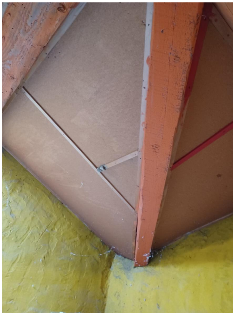
Figure 19: zone entre files 3 et 4 et files A et D - retombées de pannes et arêtiers
