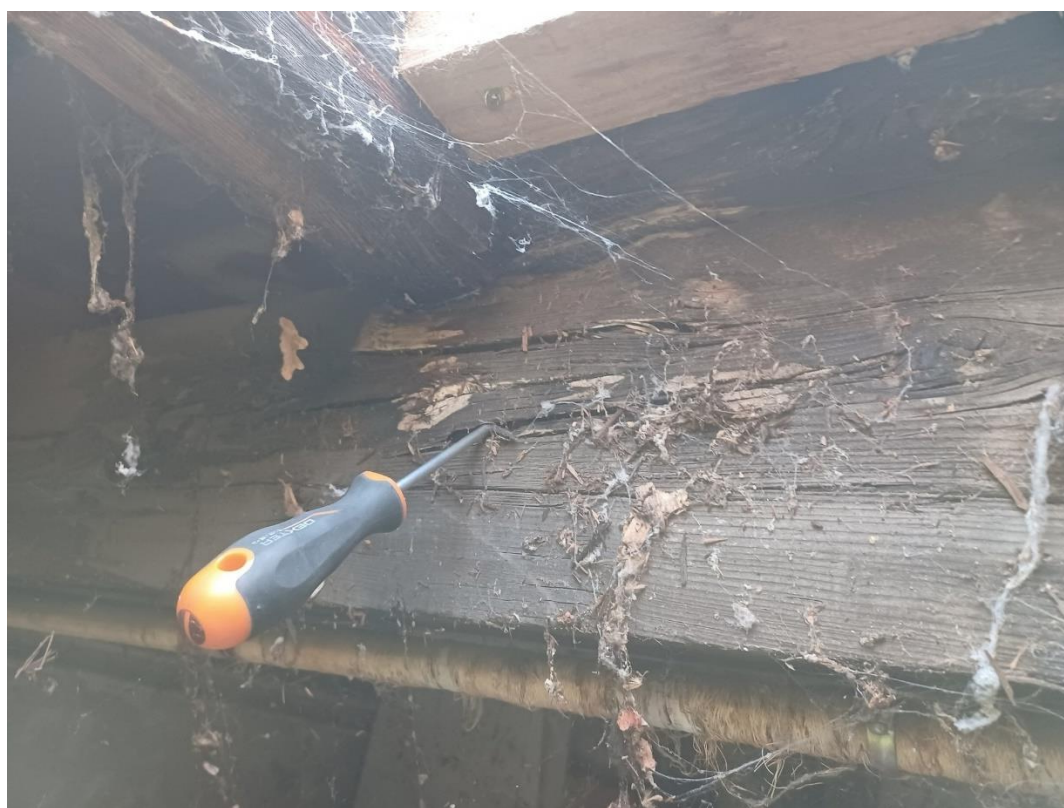
Figure 32: zone entre files 2 et 3 et files B et C - panne altérée vers chevêtre
