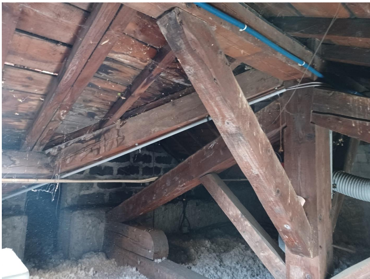
Figure 27: zone entre files 2 et 3 et files B et C - vue générale ; infiltrations
