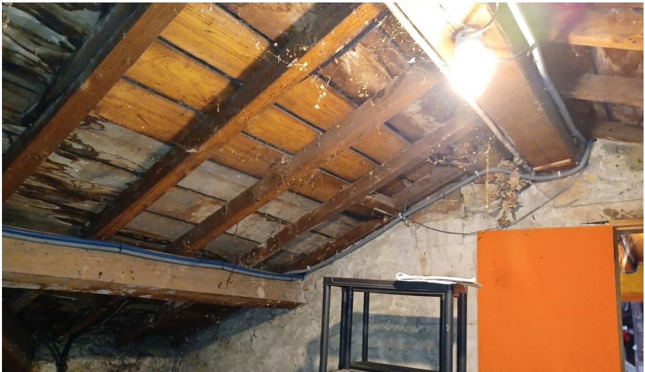
Figure 38: Zone entre files 4 et 5 et files B et C - infiltrations
